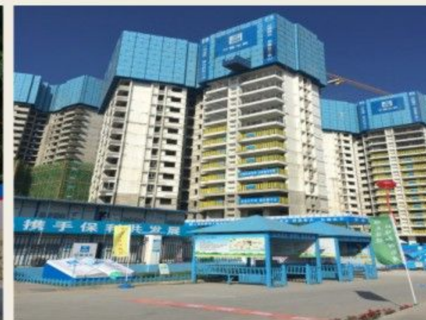
外立面采用钢丝网片防护
