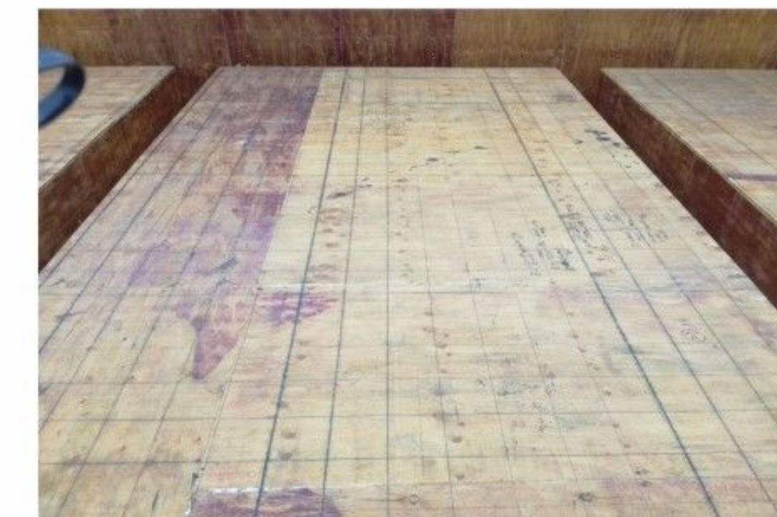
模板施工和定位弹线
