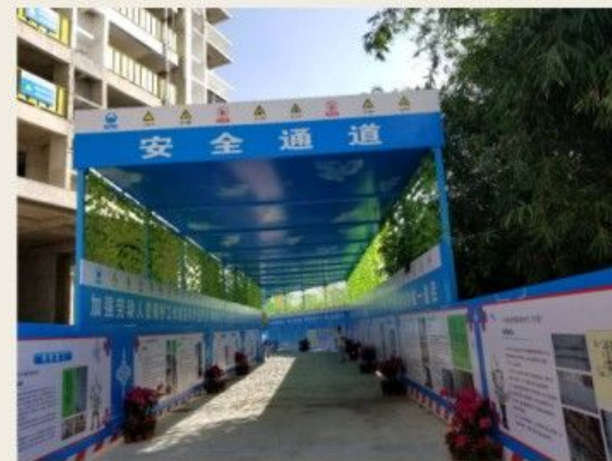
安全通道采用定型化装置，美观大方可重复利用
