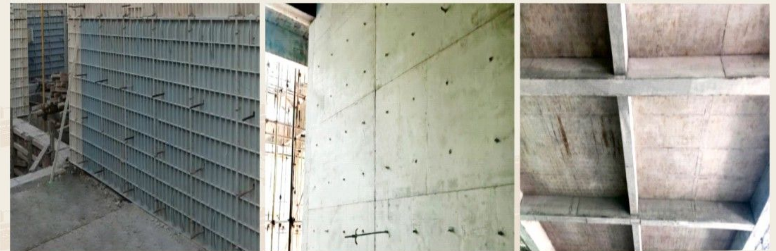
剪力墙模板安装
