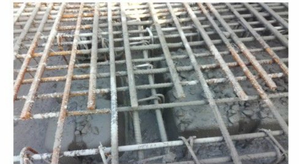
浇筑高注合金方箱混凝土空心楼盖
