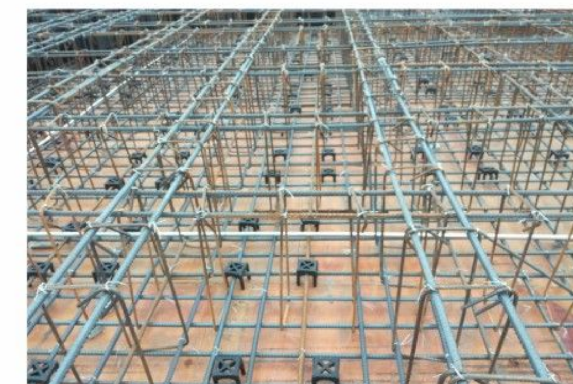
暗梁钢筋、板底钢筋及肋间钢筋安装
